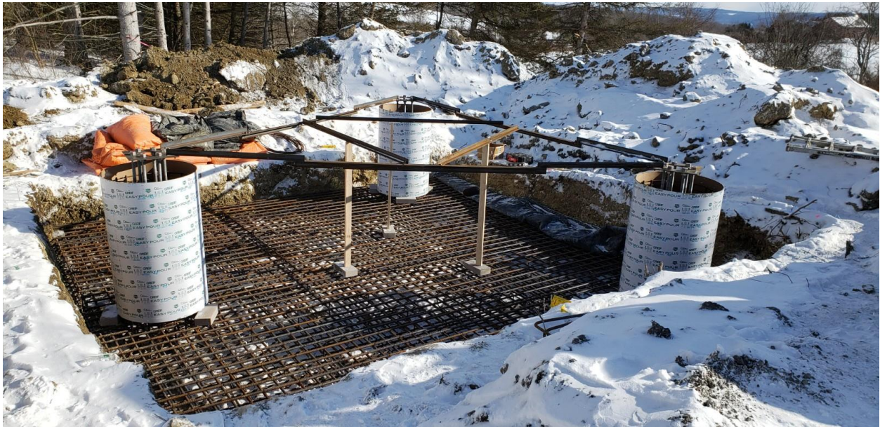
Lisle Foundation Concrete Pour
