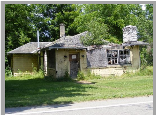
2300 Owego Rd., Town of Vestal
